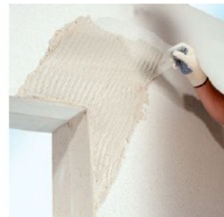
Aplikácia diagonálne výstuže
