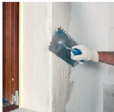
Inštalácia rohového profilu
