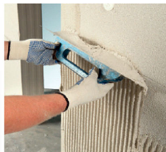
Nanášenie prvej vrstvy Ytong ľahčenej omietky
