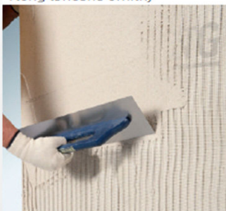
Nanášenie druhej vrstvy Ytong ľahčenej omietky „mokrý do mokrého“
