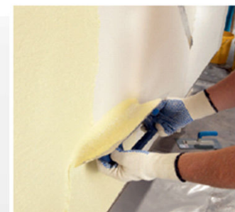
Nanášenie finálnej vrstvy podľa technologického predpisu výrobcu
