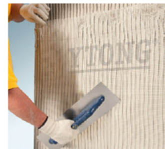
Vloženie výztužnej tkaniny Ytong
